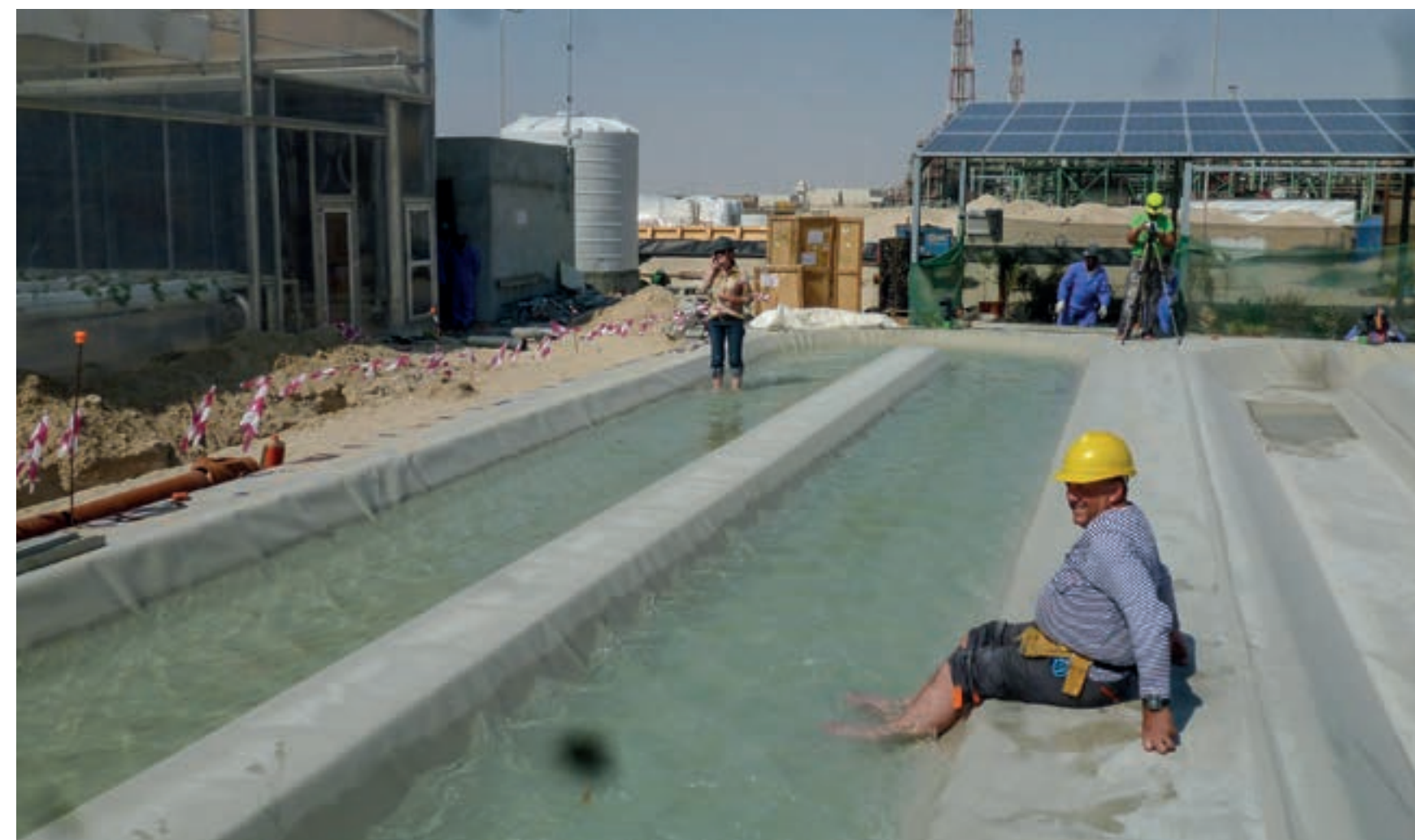
Aanleg van een vijver voor de productie van algen binnen het Sahara Forest Project.
