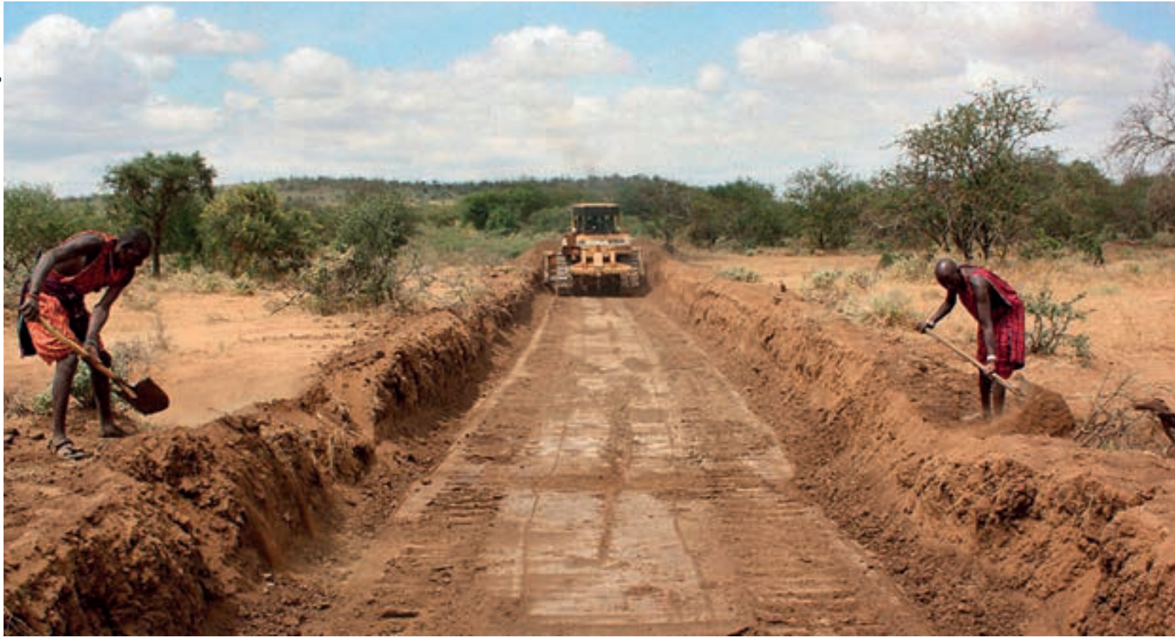
Het graven van een greppel in Kenia.
